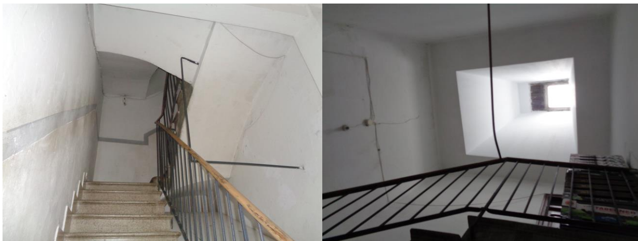
ESCALERA DE ACCESO A LAS VIVIENDAS Y LUCERNARIO SOBRE ELLA
