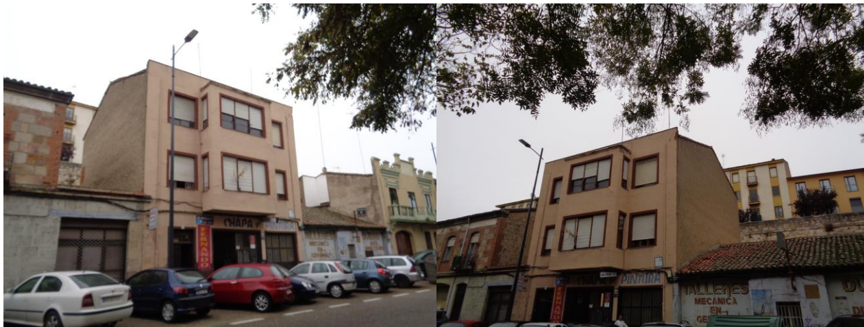
FACHADA HACIA LA AVENIDA DE LA FERIA
