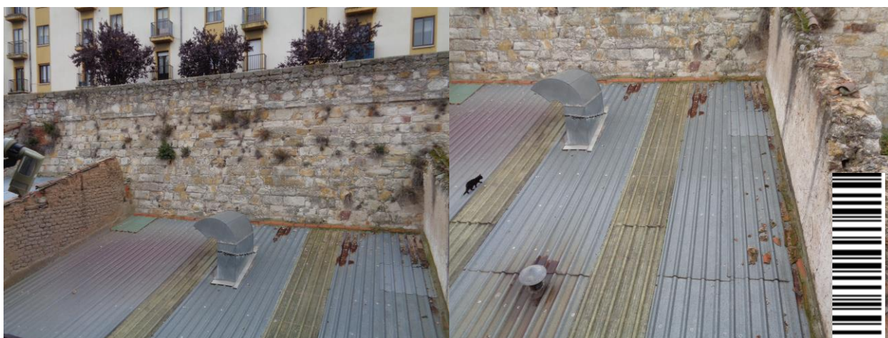
CUBIERTA DE LA NAVE QUE SE DISPONE EN LA PARTE POSTERIOR
